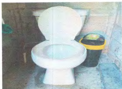
Foto 3: Sustrucion de Inodoro
