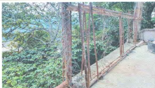
Foto 6: Reparacion de muros perimetrales de con tubo hg y malla galvanizada
