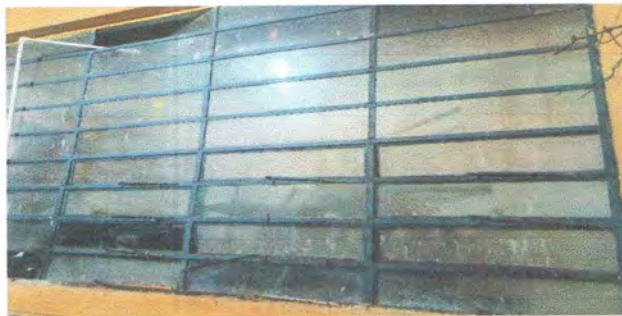
Foto 5: sustitucion de estructura de metal de ventana
