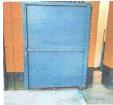
Foto 4: Sustitucion de puerta servicio Sanitario
