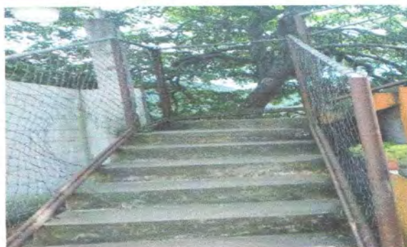
Foto 4: Suastitucion de baranda de metal S
