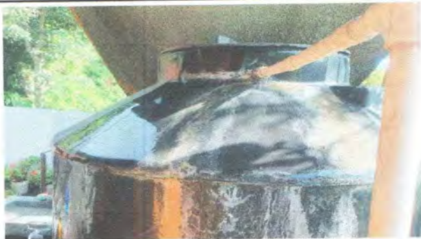
Foto 1: Sustitucion de deposito de agua 1000lts
