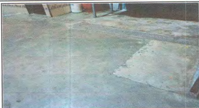
Foto 1: Sustrucion de piso ceramico
