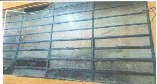
Foto 6: sustitucion de vidrios
